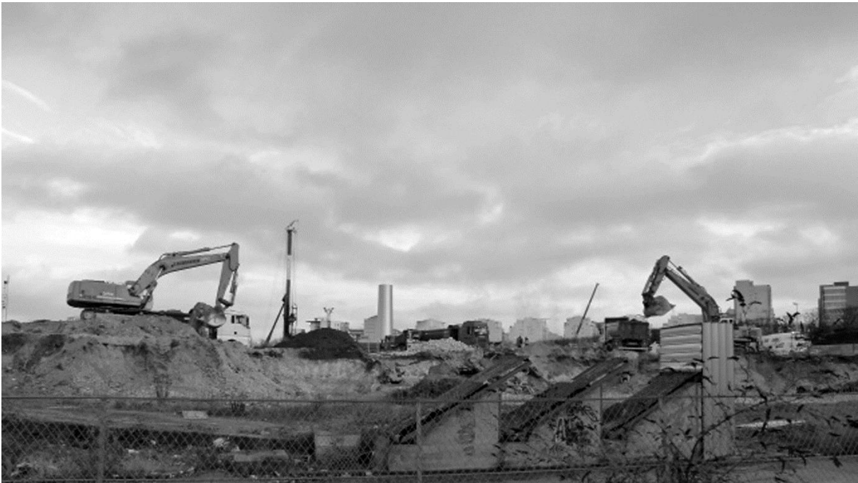
On déblaie le terrain
