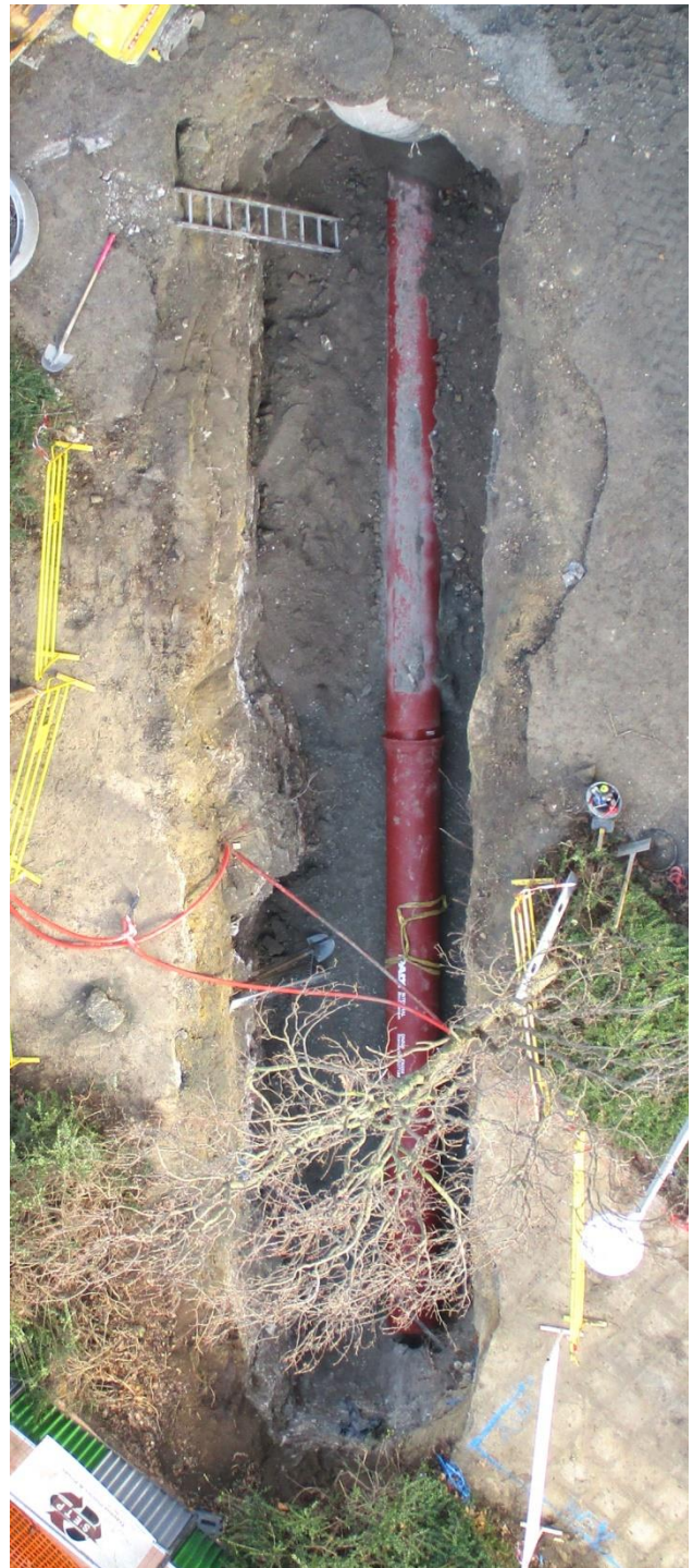
La tranchée le 19 décembre
