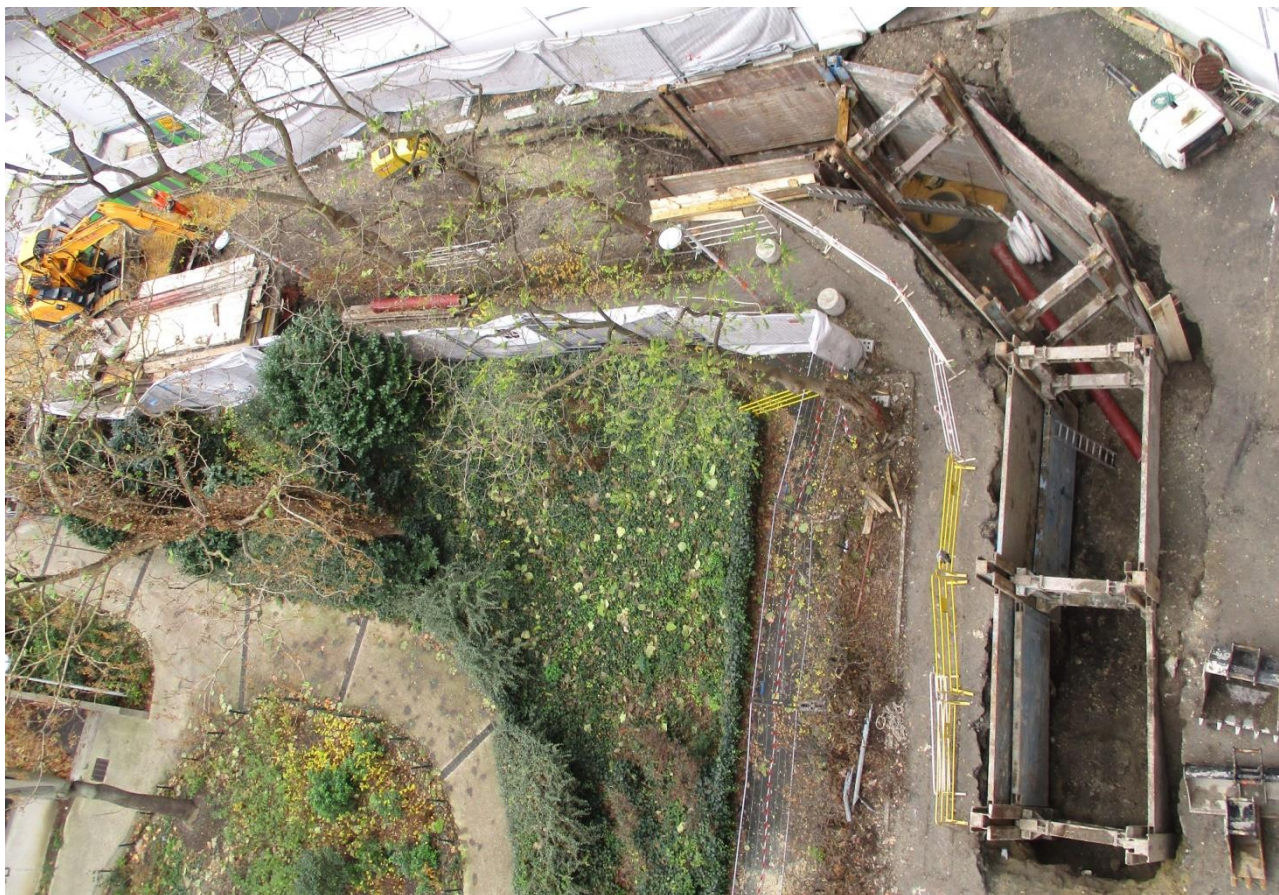
Le chantier le 29 novembre : une section remblayée, une section ouverte en tranchée blindée.
