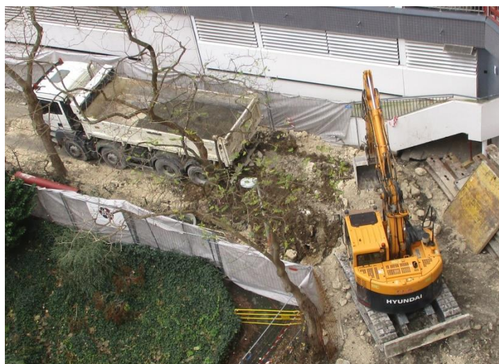
Le chantier le 29 novembre : une section remblayée, une section ouverte en tranchée blindée.
