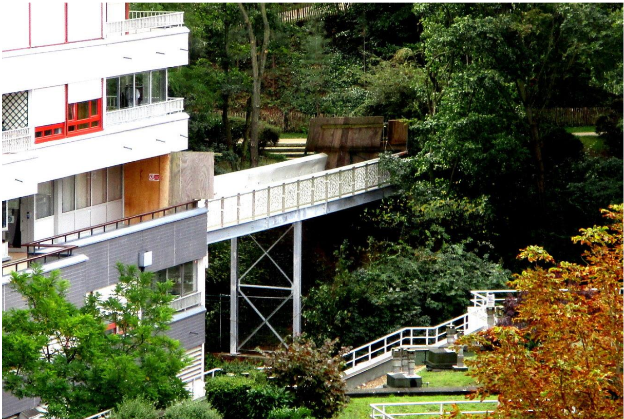
AUJOURD'HUI, 2 octobre 2021, un remplacement en voie d'achèvement.
