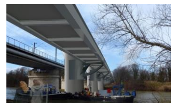
La future passerelle Nanterre -Bezons
