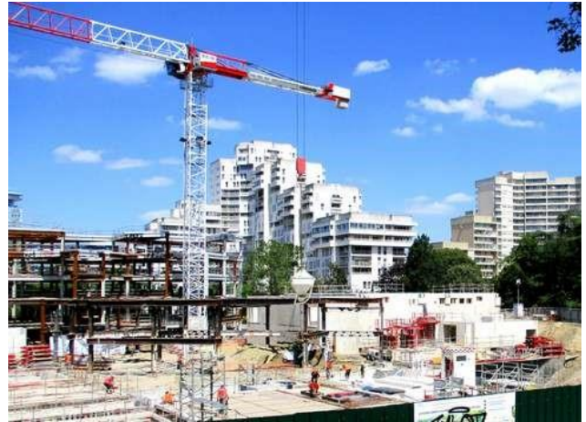
Le plot Sud également au niveau du plancher
