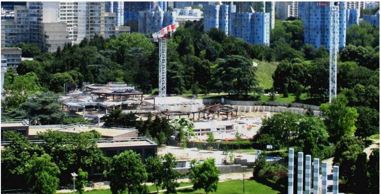
Le chantier en cours et son environnement, vus du 17 e étage du Liberté
