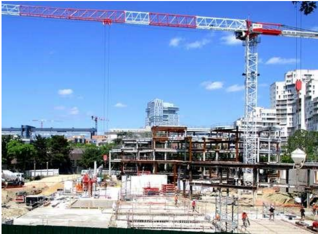
Le plot Ouest au niveau du plancher
