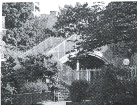
Rue de la Mare, passage au dessus de la petite ceinture.
