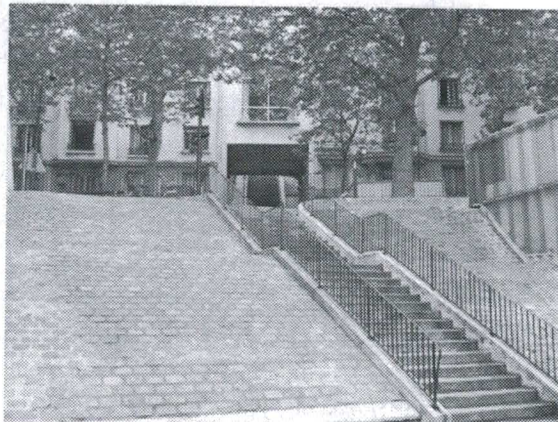
Escaliers de la rue Lauzun
