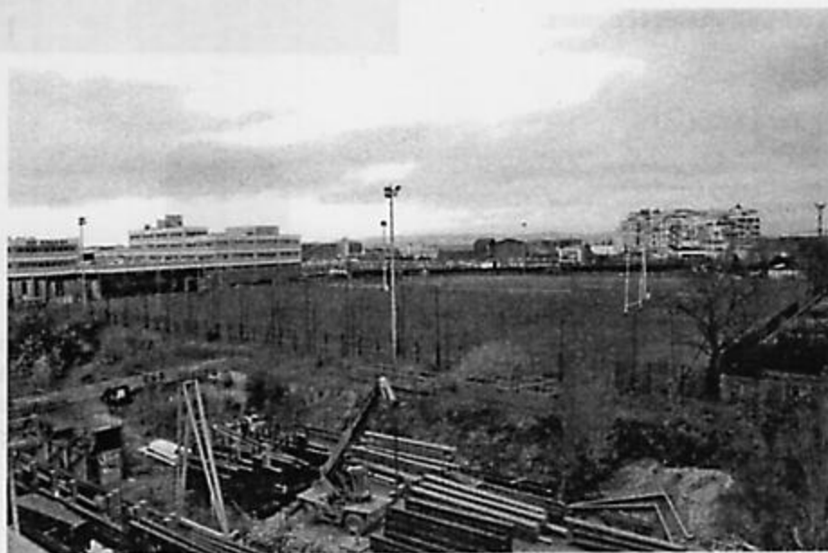
L'emplacement du stade vu du bout de la jetée.
